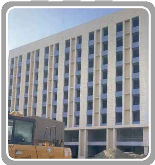
"중국 공사 현장"
