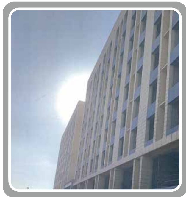
"중국 공사 현장"
